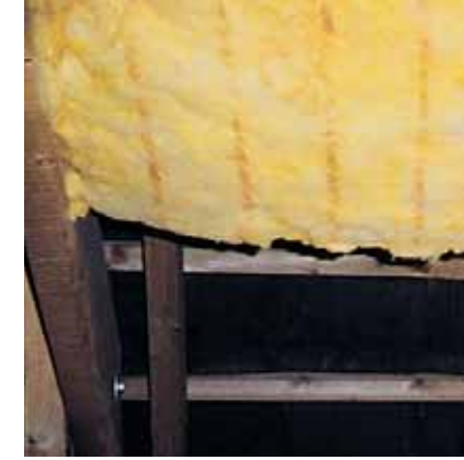
Dämmung mit Mineralwolle
