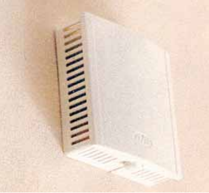
1. Zuluft über Außenwandventil
