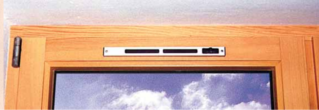
2. Zuluft als Spaltventil im Fensterrahmen
