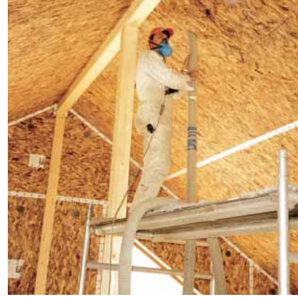
Einblasen von Zellulose
